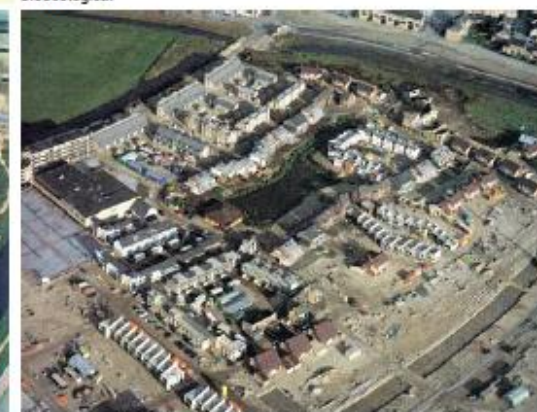
Sopra. Stato di attuazione nel 1993, vista da Ovest.
