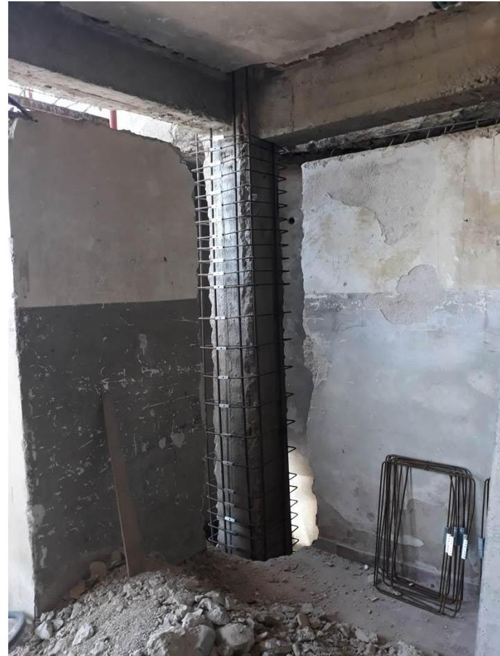
*Incamicatura di un pilastro: schema di intervento e fase di cantiere*
